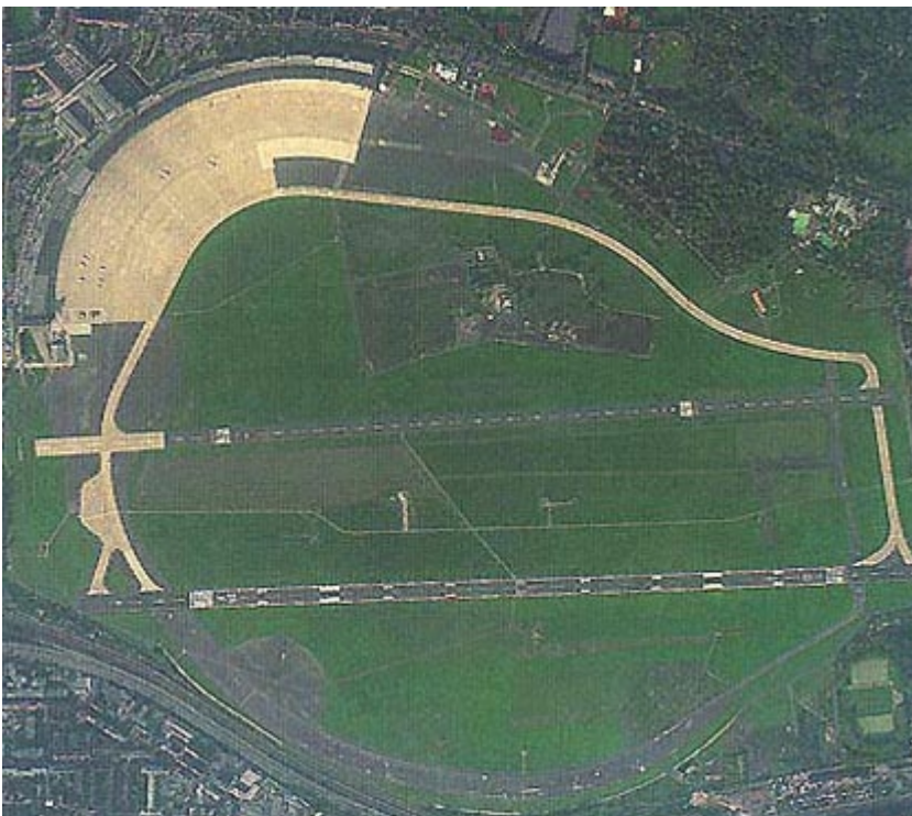
Abb.2: Unter dem ganzen oval geformten Flughafengelände ist offenbar eine unterirdische Ringantenne verlegt
